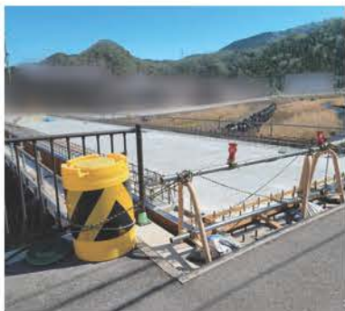
令和7年3月時点の昭和橋
